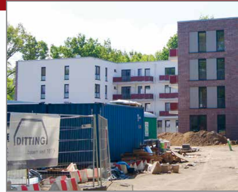
Baustelle der Wohnunterkunft Ohkamp
